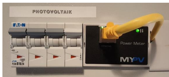
Abbildung 3: Der Power Meter wird direkt nach dem Zähler des Energieversorgers im Verteilerschrank montiert.
